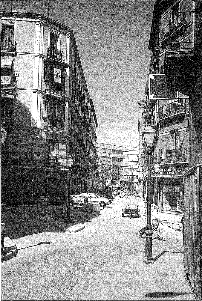
Obras de pavimentación de calles y ordenación del tráfico rodado correspondientes al itinerario de teatros en las traseras de la Gran Vía (calle Desengaño).
